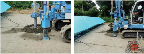
写真3 柱状改良体の施工実験
