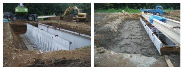
写真1 擁壁設置状況
