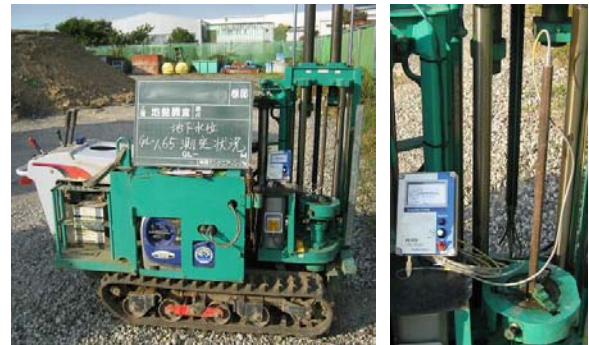
写真1 SWS試験孔を利用した地下水位測定状況
