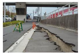
사진 3. 제방 쪽의 인도에 보이는 균열에 의한 단층 (이마가와 지구)
