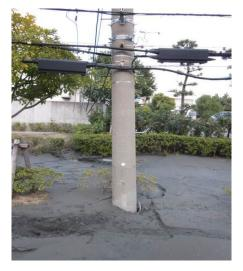
사진 1. 보도의 균열에 의해 분출된 진흙에 전봇대가 묻힌 상태 (지도리 지구)
