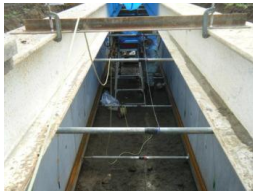
軸力計・変位計取付状況
