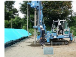
施工状況①
