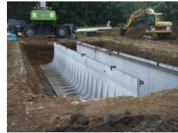
擁壁設置状況②
