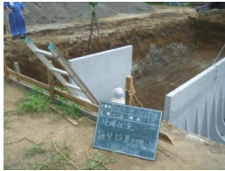
擁壁設置状況①
