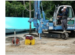
施工状況②
