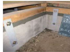
固定金物取付け
