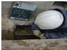
ジャッキアップ状況
