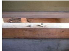
アンカーボルト取り外し
