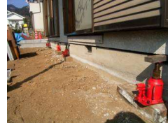
ジャッキセット状況
