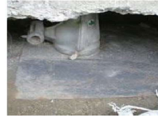
耐圧版設置状況
