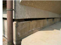
ジャッキアップ完了
