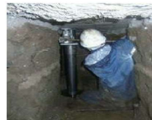
ジャッキアップ状況
