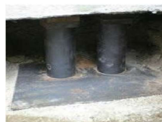
基礎本受け状況
